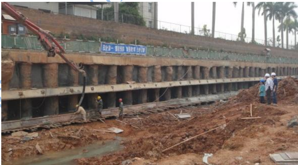
上面的是冠梁，下面的是腰梁
