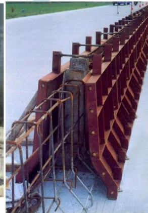
倾斜挡土墙及挡土墙上的防撞栏杆拆除新建
