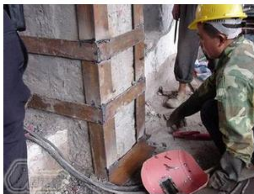
外包钢缀板焊接
