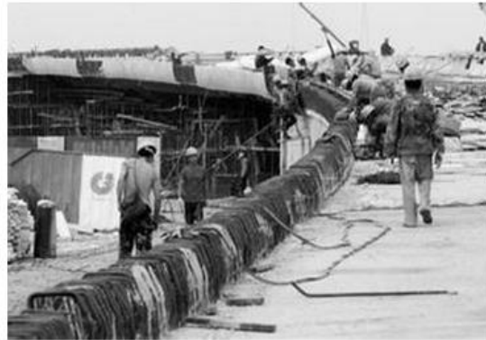
倾斜挡土墙及挡土墙上的防撞栏杆拆除新建
