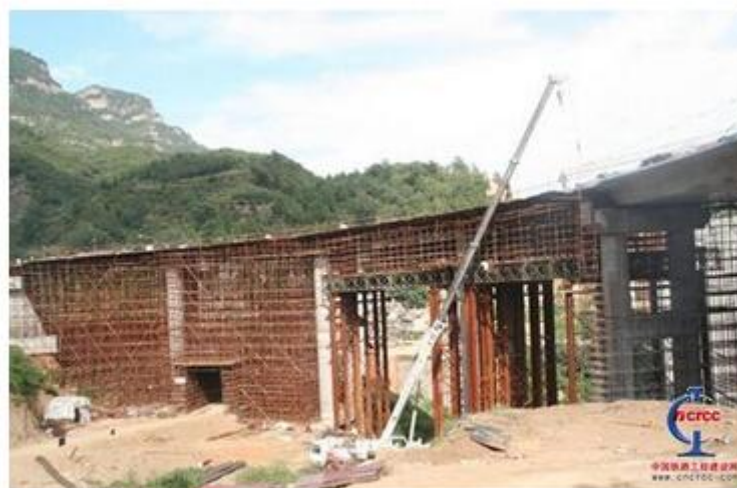
现浇箱梁满堂支架搭设完毕
